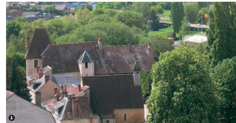
1 Vue du château et de la chapelle Saint-Lyphard depuis le clocher de Notre-Dame-des-Marais. 2 L'entrée du château au début du XIX e siècle. Au premier plan la tour-porche, à gauche la chapelle Saint-Lyphard, à droite la tour du Trésor. Peinture sous verre, mairie de La Ferté-Bernard. 3 Église Notre-Dame-des-Marais, vitrail de l'Ecce Homo offert par la famille Heullant, détail des donateurs, bas-côté Sud du chœur, vers 1540 et XIX e siècle.
