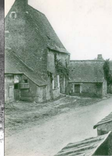
La Cassinerie avant la transformation de sa façade.
