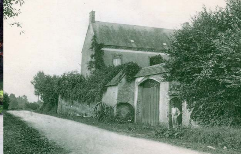
Le presbytère de Tresson avant la destruction du mur de clôture.
