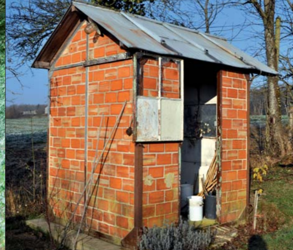
Le tramway : ancienne gare de Tresson, actuellement au Grand-Lucé. © J. Dangeul
