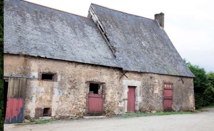
Ancien logis et bâtiments agricoles de Vauboulon à Tresson.
