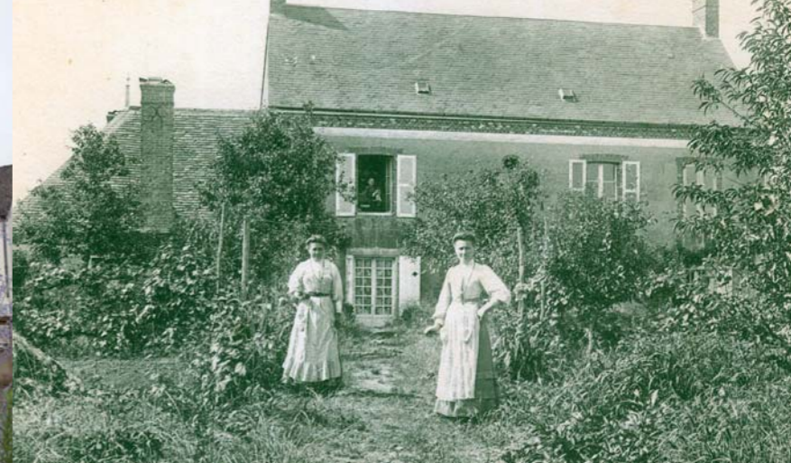
Vue arrière de l'ancien presbytère.
