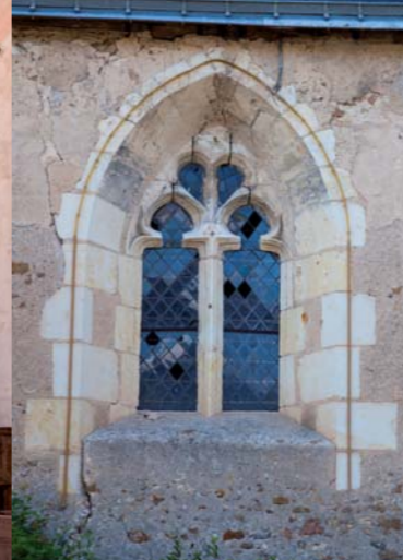
Eglise. Baie du mur Sud.
