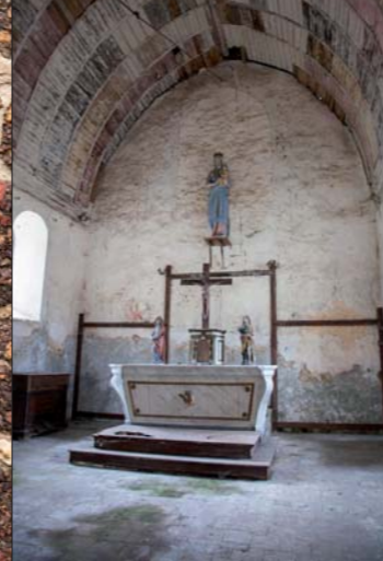
Vue du chœur de l'église.
