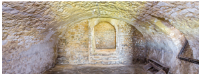
La cave voûtée du manoir et son ancienne porte d'accès.
