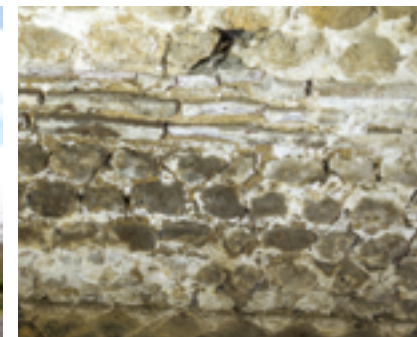
Un détail des substructions antiques du manoir de la Cour.
