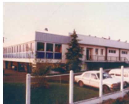
L'usine Bahier en 1972 (collection entreprise Bahier).
