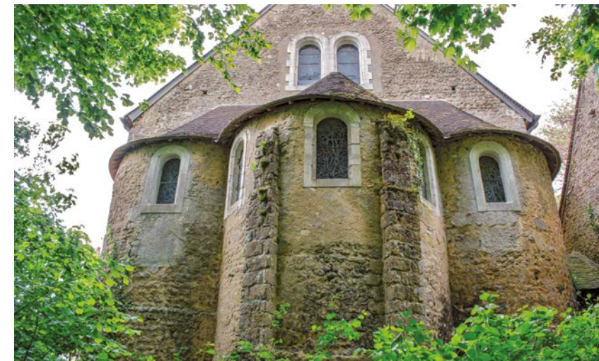
Le chevet de l'église Saint-Gilles et ses trois absides (photo Perche Sarthois).
