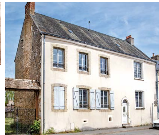
La maison du Grand Chardon côté rue.
