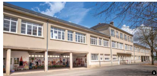
Le groupe scolaire ❶. Un des escaliers du groupe scolaire ❷.
