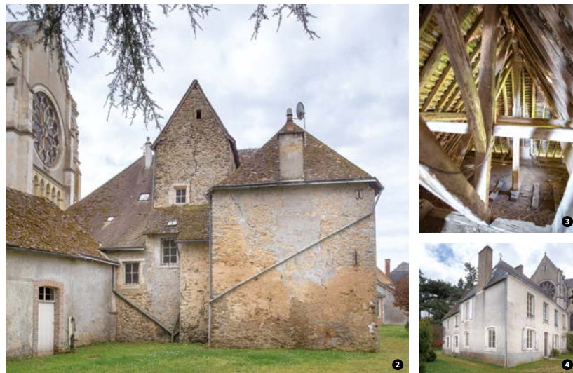
La place, l'ancienne église et le presbytère sur le cadastre de 1836 (Archives départementales de la Sarthe, 3 P 208) ❶. La façade arrière du presbytère et la tour d'escalier ❷. Un détail de la charpente du presbytère ❸. Les façades principales du presbytère ❹.
