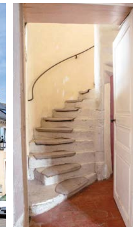
L'escalier à vis.
