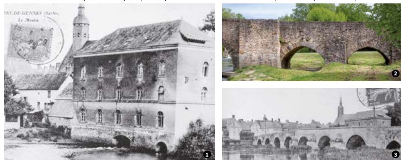
Le moulin avant son incendie, carte postale du début du XX e siècle (collection particulière) ❶. Un détail des arches médiévales du pont ❷. Le pont, carte postale du début du XX e siècle (collection particulière) ❸.
