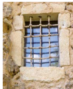
Un détail d'une ouverture pourvue d'une grille.
