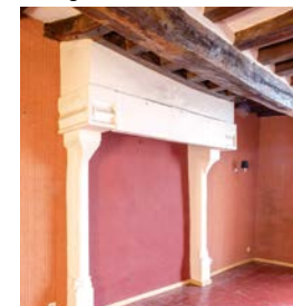
Une cheminée à l'étage de la maison.
