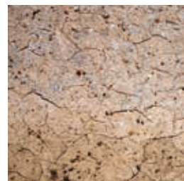
Les Hayes, Tresson Enduit ancien plein et lissé. L'enduit laisse apparaître de micro-fissures (faiencage) peut-être liées à une surdose de chaux mais surtout à une granulométrie irrégulière et de subtiles nuances liées à la patine du temps.
