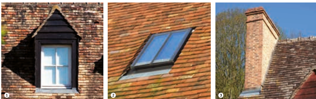
Exemples de créations d'après les modèles traditionnels : ❶ lucarne à St-Aubin-des-Coudrais, ❷ petite fenêtre de toit imitant les anciens châssis en fonte à Dollon, ❸ souche de cheminée à St-Denis-des-Coudrais
