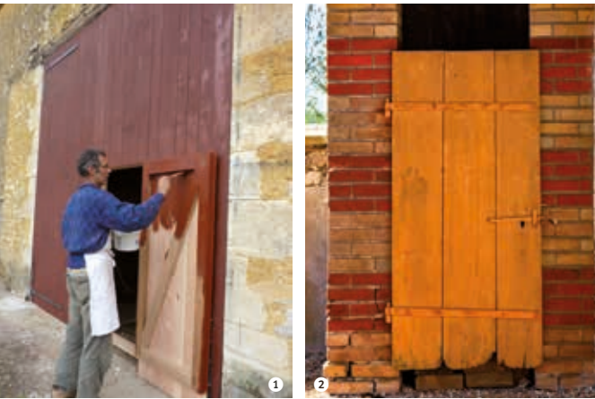
Peinture "fabrication maison" à la farine et à l'oxyde de fer rouge et à l'ocre jaune. ① La Hupetière, Cherreau - ② Ancienne école, La Bosse
