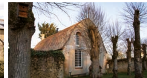
Toit en carène de l'ancienne orangerie de Pescheray, Le Breil-sur-Merize
