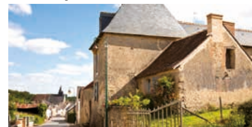
Toit en pavillon et toit en bâtière, maison de bourg, Conflans-sur-Anille
