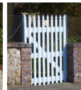
Portails d'accès à une maison, bourg de Vouvray-sur-Huisne
