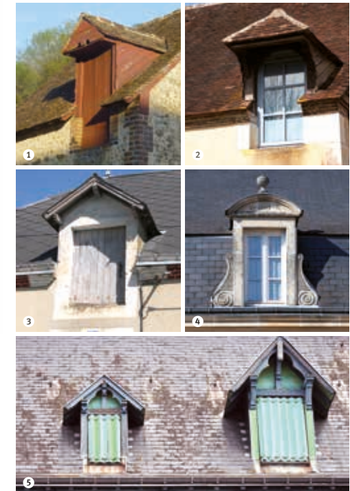
Différents types de lucarnes : modèles traditionnels sur les bâtiments agricoles, en bâtière et à capucine à St-Denis-des-Coudrais ❶, La Chapelle-Huon ❷ ; modèle en pierre, lucarne traditionnelle à Théligny ❸ et lucarne à fronton XIX e s. à La Ferté-Bernard ❹ ; lucarne de style néo-régionaliste, vers 1906, Rue Alfred Marchand à la Ferté-Bernard ❺
