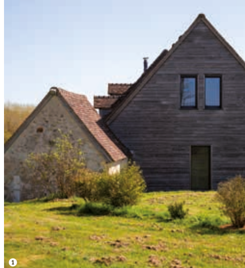
1 2 Extension contemporaine de 50 m 2 au sol d'une maison ancienne à St-Georges-du-Rosay. Réalisation en ossature bois (bardage en douglas) par Stéphane Leroux, Nogent-le-Bernard (2007)
