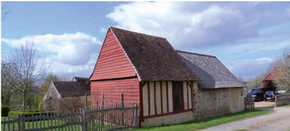
La Petite Ruche, Tresson. Réalisation d'un bardage horizontal peint en pignon par Pascal Chosson
