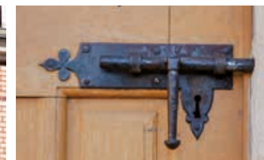
Manoir de La Cour, Coudrecieux. Serrure-vertevelle inspirée d'un modèle du XV e s. Réalisation 2007 par Dany Bazillier (Métallerie Cénomane)
