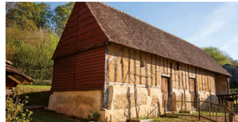
Le Val, St-Denis-des-Coudrais. Étable-remise XVII e siècle en pan-de-bois restaurée en 2010-12 par Bruno Haton (charpentier-couvreur, Bouëx) et Pascal Chosson (maçon, Tresson) et le propriétaire (torchis)
