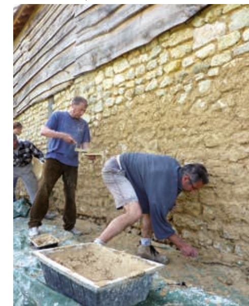
Atelier de réalisation d'un enduit traditionnel, La Hupetière, Cherreau
