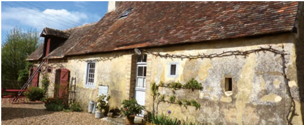
La Petite Ruche, Tresson. Maison restaurée dans les années 2000. L'enduit ancien n'a pas été refait en totalité, seules des retouches ont été réalisées en se rapprochant au maximum de la couleur et de la texture de l'enduit existant. Il n'a pas été patiné mais il est possible de le faire afin d'imiter le vieillissement de l'enduit d'origine.
