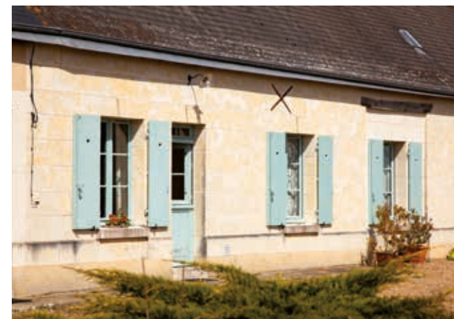
Maison rurale avec façade principale en pierre de taille, au sud du Pays Calaisien
