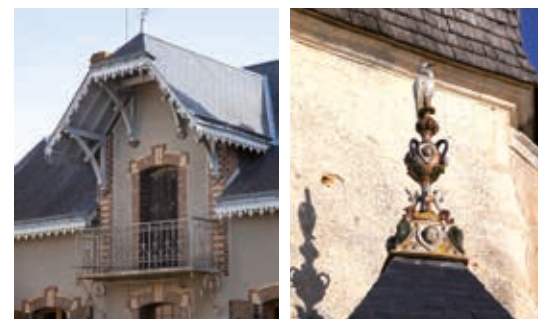
Détails de lambrequins, maison de bourg, Montaillé
