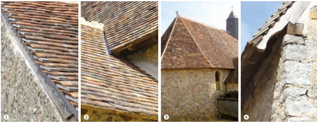
Chapelle du cimetière, Bouloire. Restauration de toiture en 2009 par Pascal Rocheteau, charpentier-couvreur à Dollon ❶ chevron de rive affleurant et rive alternant tuiles et bardeaux de chataignier, ❷ noue et égoût avec chanlatte épaisse, ❸ arêtier réalisé à la chaux hydraulique naturelle et épi de faitage, ❹ coyau à queue de renard
