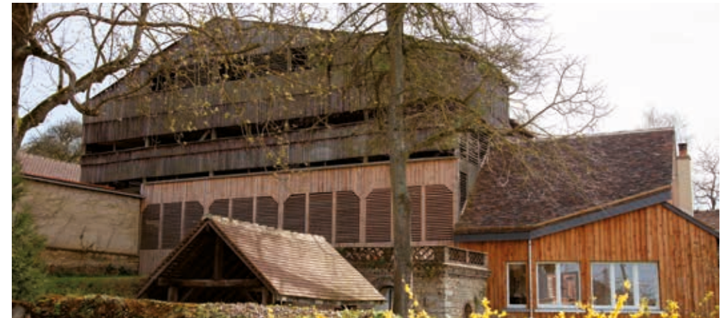
Ancien bâtiment artisanal et maison avec bardages verticaux, St-Calais
