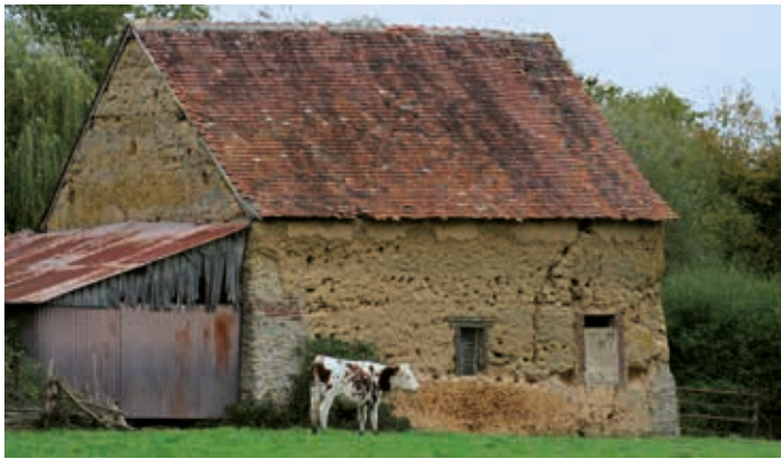
Bâtiment agricole en bauge, Le Tertre, Vibraye
