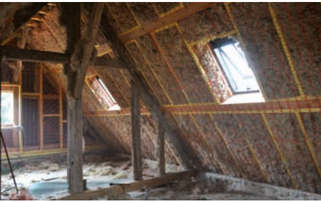
La Ménardière, Dollon. Isolation de combles à l'aide de chanvre en vrac mis en œuvre par insufflation. Lors de la réfection de la charpente, l'artisan a prévu les caissons. Mise en œuvre de l'isolation par les propriétaires. Suivi de chantier SCIC Ecopertica
