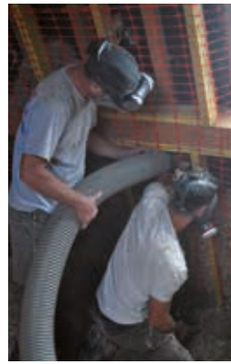
La Ménardière, Dollon. Isolation de combles à l'aide de chanvre en vrac mis en œuvre par insufflation. Lors de la réfection de la charpente, l'artisan a prévu les caissons. Mise en œuvre de l'isolation par les propriétaires. Suivi de chantier SCIC Ecopertica
