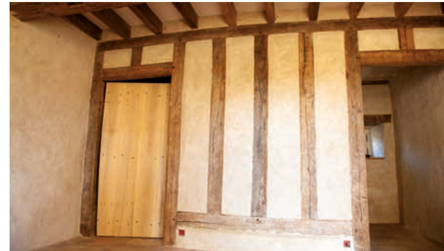
Réhabilitation énergétique d'un bâtiment ancien à l'aide d'une isolation au mortier chaux-chanvre et enduit à la chaux aérienne à St-Denis-des-Coudrais
