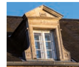
Exemple d'isolation thermique et phonique par la pose d'une double fenêtre, Torcé-en-Vallée
