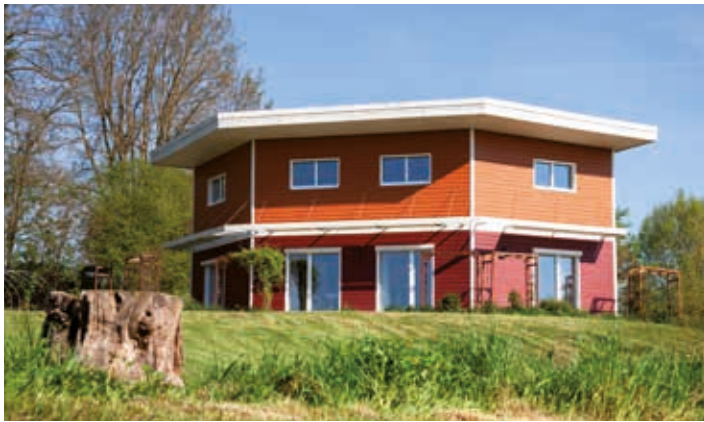
Maison passive en paille et ossature bois près de La Ferté-Bernard. Réalisation Société Isopaille - Cherré en 2012
