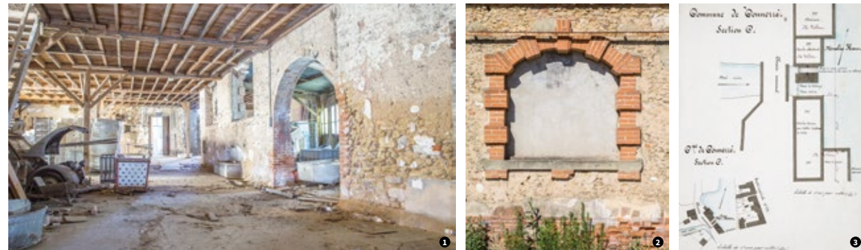
L'intérieur du bâtiment, état en 2018 ❶. Une des baies donnant sur la rue des Vieux Ponts ❷. Le plan de l'usine en 1865 (Archives départementales de la Sarthe, 7 S 153) ❸.
