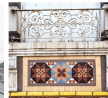
Détail de décors en céramique d'une maison de l'avenue.
