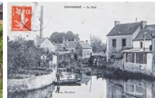
Des maisons en bord du Dué et l'ancienne cheminée de la fabrique de toiles, carte postale du début du XX e siècle (collection particulière).
