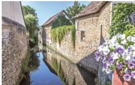
Une portion du mur d'enceinte longeant le Dué.
