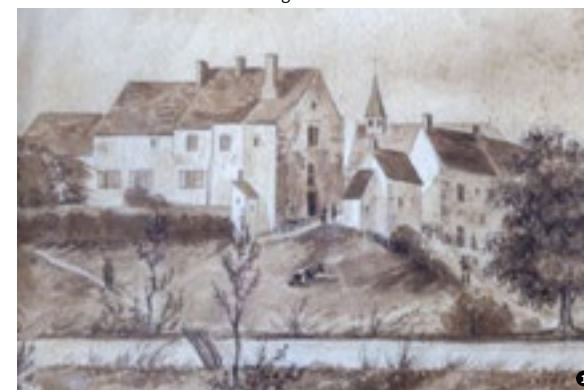
Le manoir et ses dépendances, dessin du XIX e siècle (collection particulière) ❶. Un détail d'une baie chanfreinée en grison ❷. Les ouvertures de la cave du manoir ❸.
