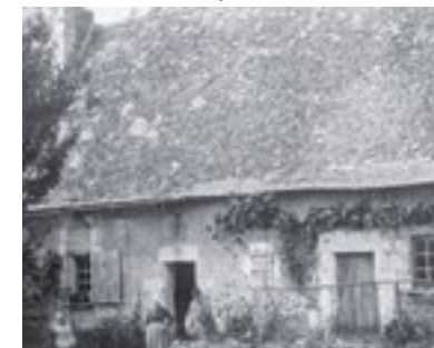
La maison du Pont photographiée au début du XX e siècle (collection particulière).
