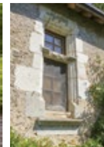
Une fenêtre à encadrement mouluré et traverse.
