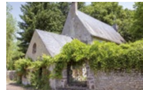
La maison du Pont.
