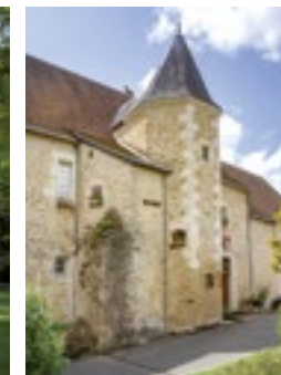
La tour d'escalier.
