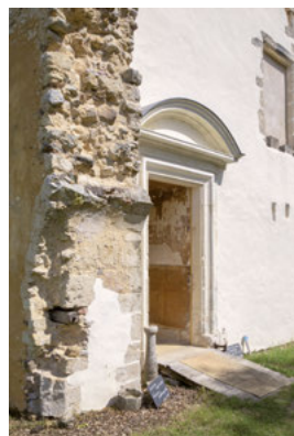
L'ancien mur pignon du logis médiéval, englobé dans le pavillon du XVII e siècle, conserve la trace des ogives qui couvraient le réfectoire médiéval et juste au-dessus, le niveau horizontal du plancher du dortoir placé dans le comble. Région des Pays de la Loire, Inventaire général, P-B Fourny
