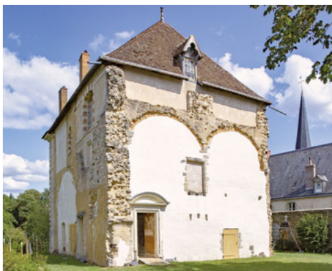
L'ancien mur pignon du logis médiéval, englobé dans le pavillon du XVII e siècle, conserve la trace des ogives qui couvraient le réfectoire médiéval et juste au-dessus, le niveau horizontal du plancher du dortoir placé dans le comble. Région des Pays de la Loire, Inventaire général, P-B Fourny
